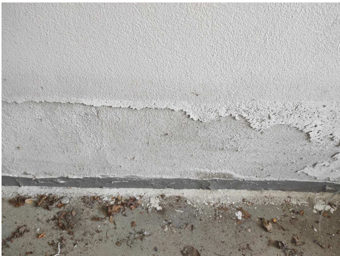
Rys. 2. zawilgocenie ściany w pomieszczeniu budynku gospodarczego
