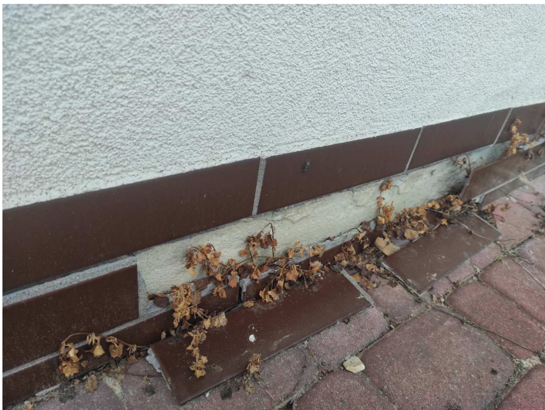
Rys. 1. uszkodzenia podmurówki budynku gospodarczego
